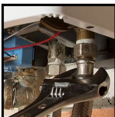
Oude CV- ketels vervangen
