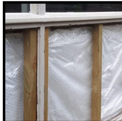
Isoleren panelen tussen kozijnen
