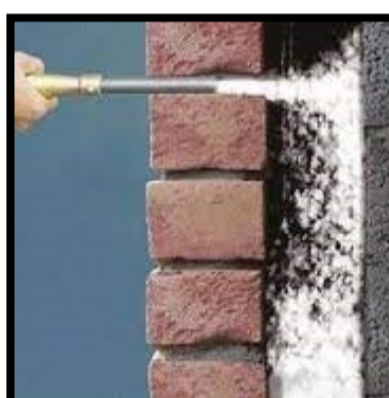
Spouw na-isoleren
